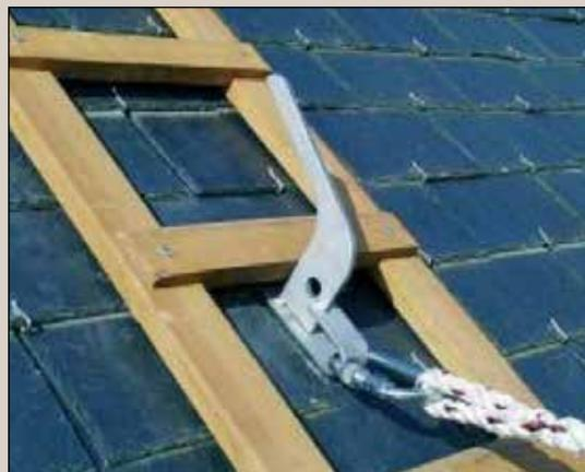
Fixation à un crochet de sécurité
