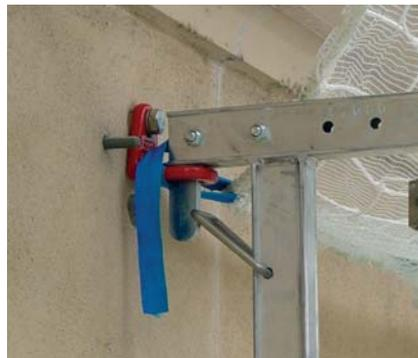
Fig. 4 – Fixation d'une console
