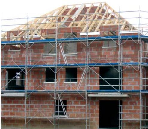
Fig. 8 Échafaudage MDS servant les travaux de ravalement, de charpente et de couverture\*
