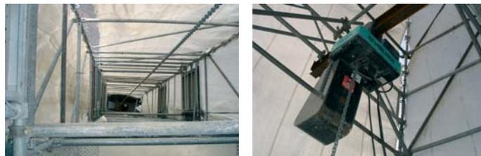
Fig 39 – Treuil installé dans une sapine
