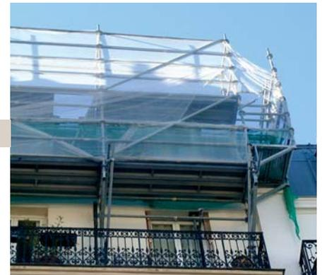
Fig. 11 – Planchers de travail – protection bas de pente - sur échafaudage multidirectionnel avec appuis balcon
