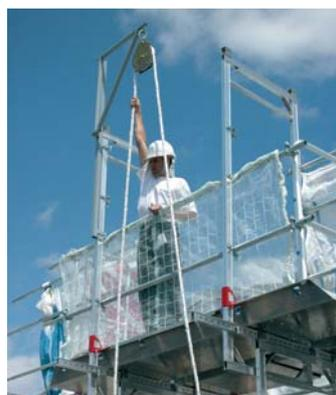
Fig 39 – Treuil installé dans une sapine
