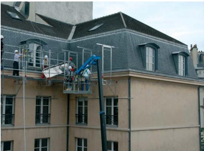
Fig. 26 – Pose de l'échafaudage à l'aide d'une PEMP
