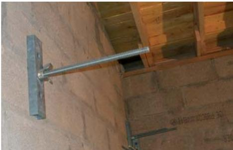
Fig. 1 – Ancrages traversants d'une console d'échafaudage
