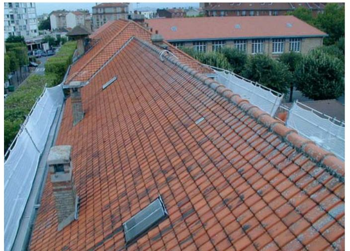
Fig 28 Protections bas de pente vues du toit
