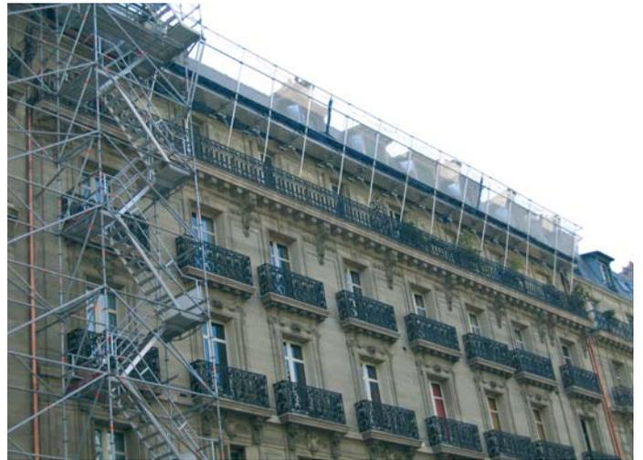
Fig 27 – Échafaudage sur consoles métalliques
