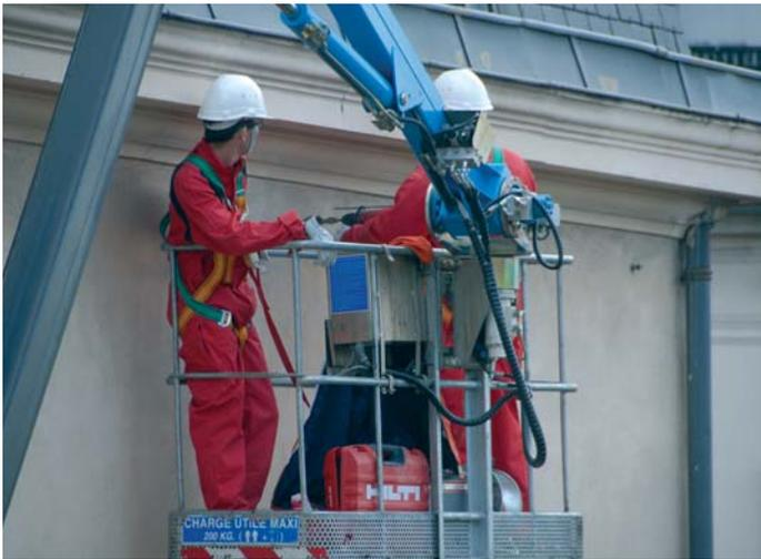
Fig. 25 – Pose des ancrages pour les consoles
