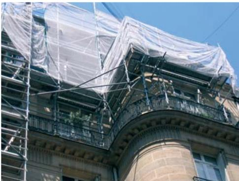
Fig 13, 14 – Plancher de travail sur échafaudage en appui sur balcon et tour d'accès dans courette
