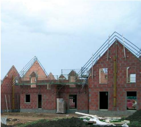
Fig. 6 – Garde-corps en rive de toiture
