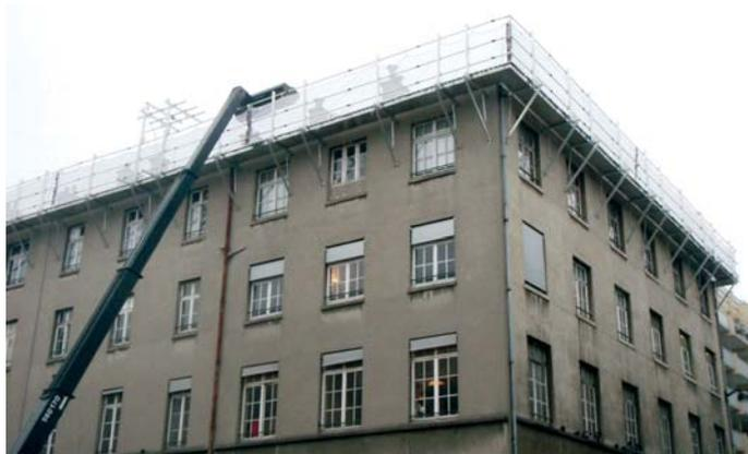
Fig. 38 – Opération d’approvisionnement d’un chantier
